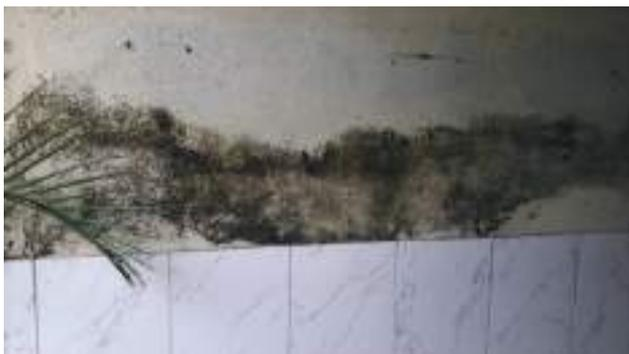
**Figura 17.** Mofo em parede do segundo pavimento
