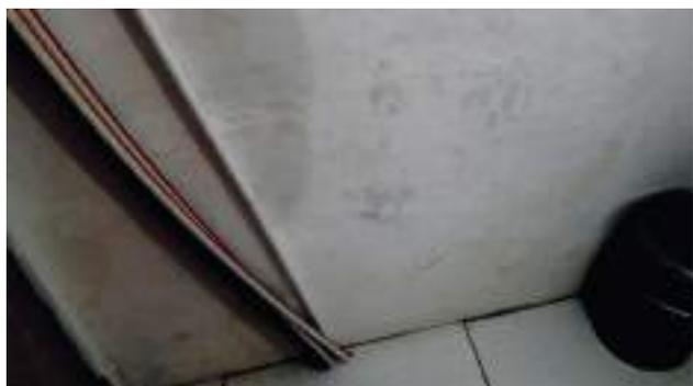
**Figura 15.** Manchas na parede em contato com banheiro
