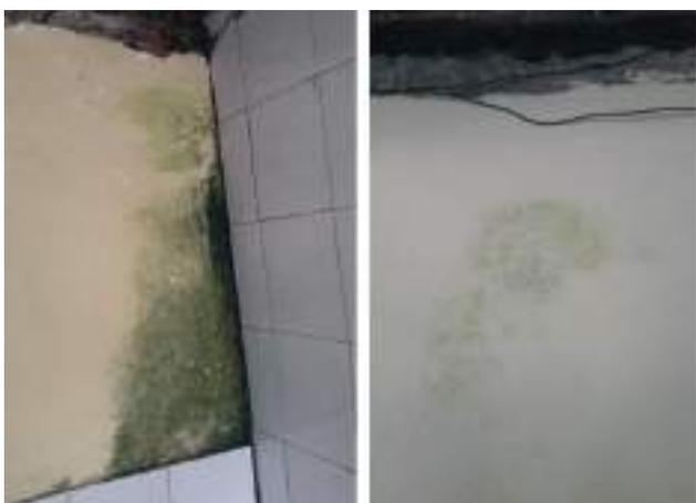
**Figuras 18.** Mofo em parede do segundo pavimento
