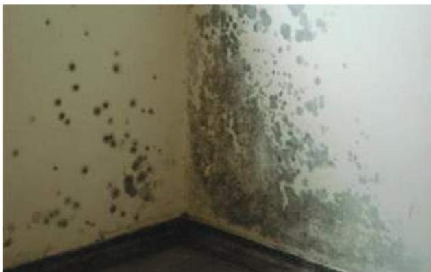
**Figura 2.** Parede com mofo
