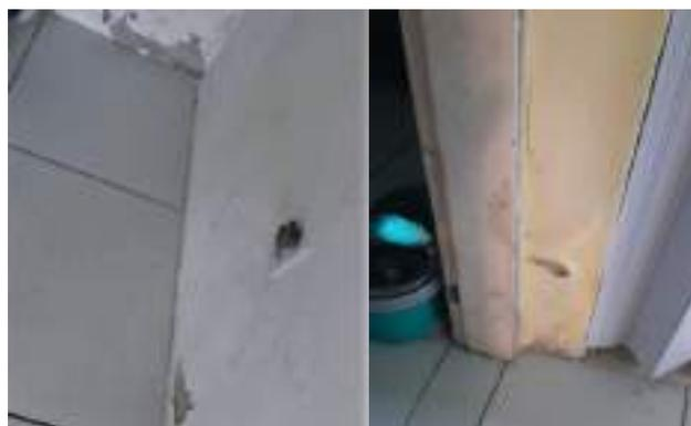
**Figura 13.** Desagregamento tintas na parede da varanda em contato com o banheiro
