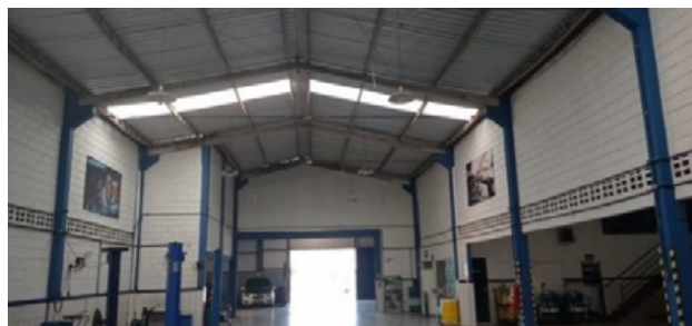
Figura 1. Vista interna da oficina.
